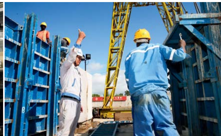
2017年5月10日，肯尼亚拉穆港项目现场，中国技术人员与肯尼亚员工一起紧张施工。2012年3月，肯尼亚联合南苏丹和埃塞俄比亚启动了“拉穆港-南苏丹-埃塞俄比亚交通走廊”项目。项目包括铁路、公路和石油管线等诸多组成部分。同年，中国交建获得拉穆港项目的承建权，助力肯尼亚古老海港焕发生机。 摄影 潘思危/新华社
