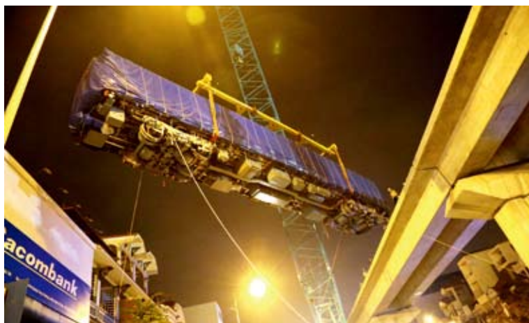
2017年2月21日，在数百名围观群众的掌声和欢呼声中，中国专为越南首条轻轨定制的第一辆列车车厢被成功吊装上桥。中铁六局 供图
