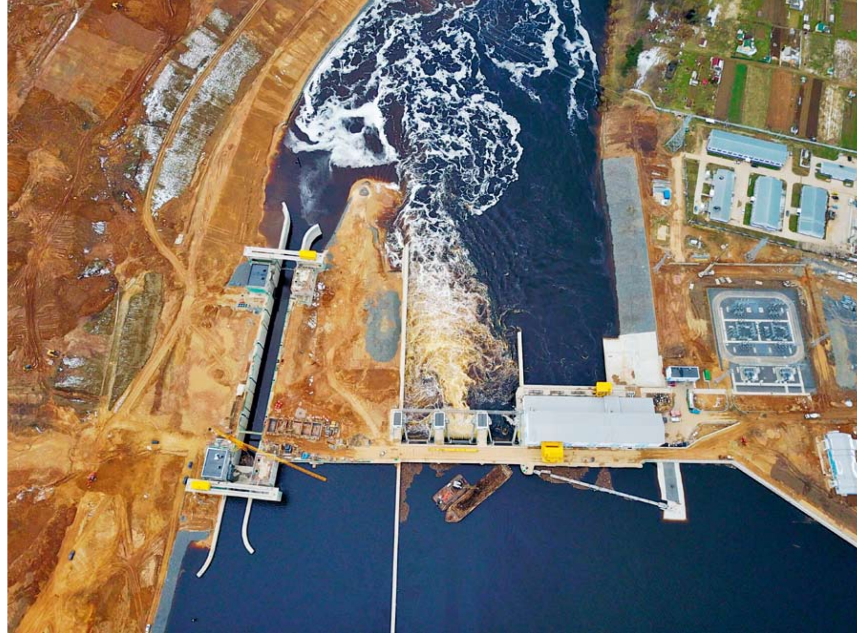
2017年4月，白俄罗斯维捷布斯克水电站枢纽区全景。该水电站由中国电力工程有限公司承建，是白俄罗斯最大的水电工程。它于2013年开始导流施工，计划今年7月完工交付当地能源局。 摄影 白雪琪/新华社
