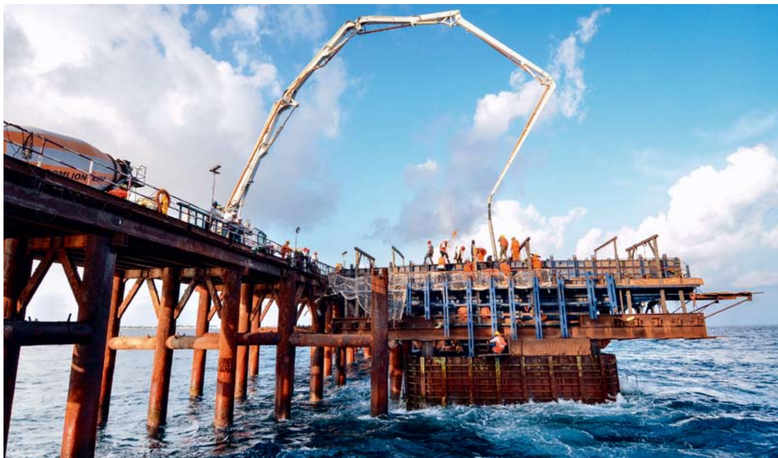
2017年4月21日，中马友谊大桥首个墩身成功浇筑，世界首座建在珊瑚礁上的跨海大桥正在如火如荼建设中。大桥连接马尔代夫首都马累和机场岛，使天堑变通途。中马友谊大桥是“21世纪海上丝绸之路”的重点项目，是中马友谊的重要见证。 新华社 供图
