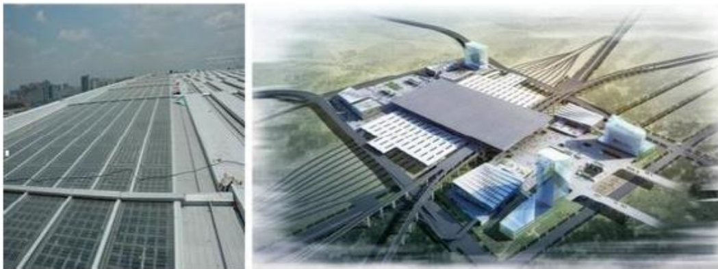
图 3：深圳北站节能帷幕系统、建筑光伏电站总承包项目
