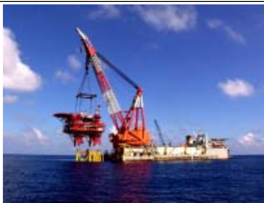
LF13-2 组块海上安装
